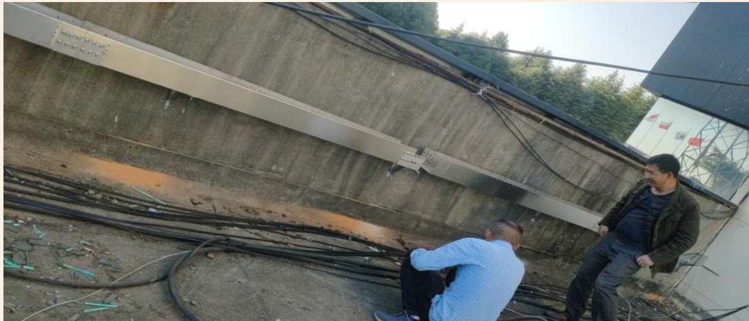
(东二、四主电缆电力改造桥架安装中)
