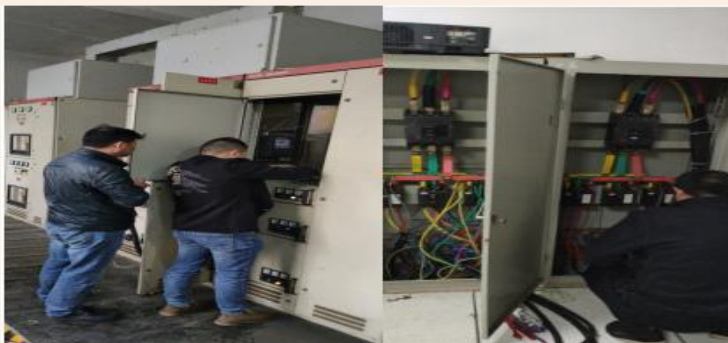
(对供电设备进行维护、维修)
