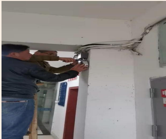
(更换东区3楼电铃)
