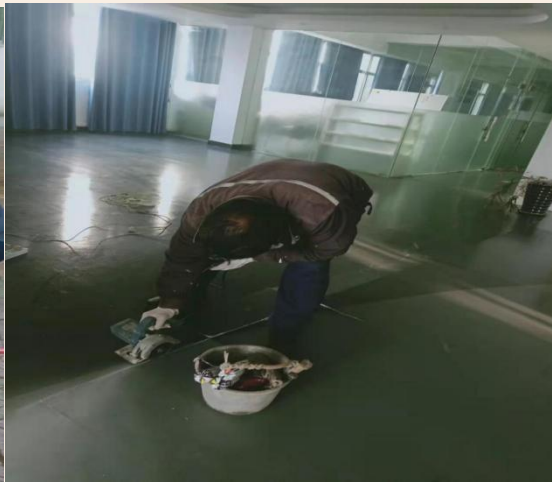
(东三栋地砖变形切割修补)
