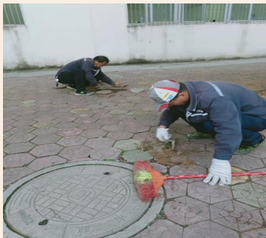
(修复松动破损的地砖)
