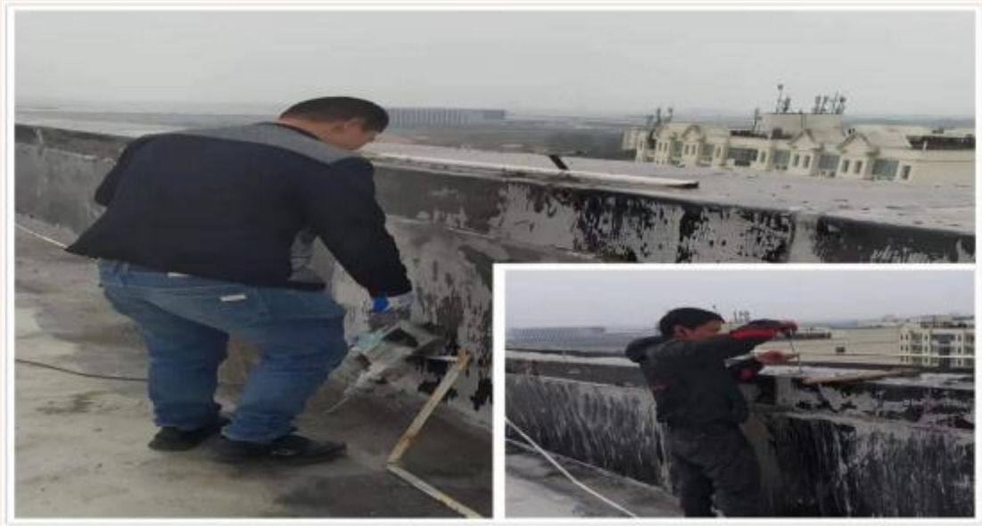
(主教学楼楼顶安装 9+9 防雷系统)
