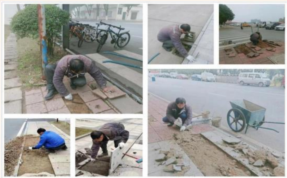
(维修室外地面学生宿舍地面修复)
