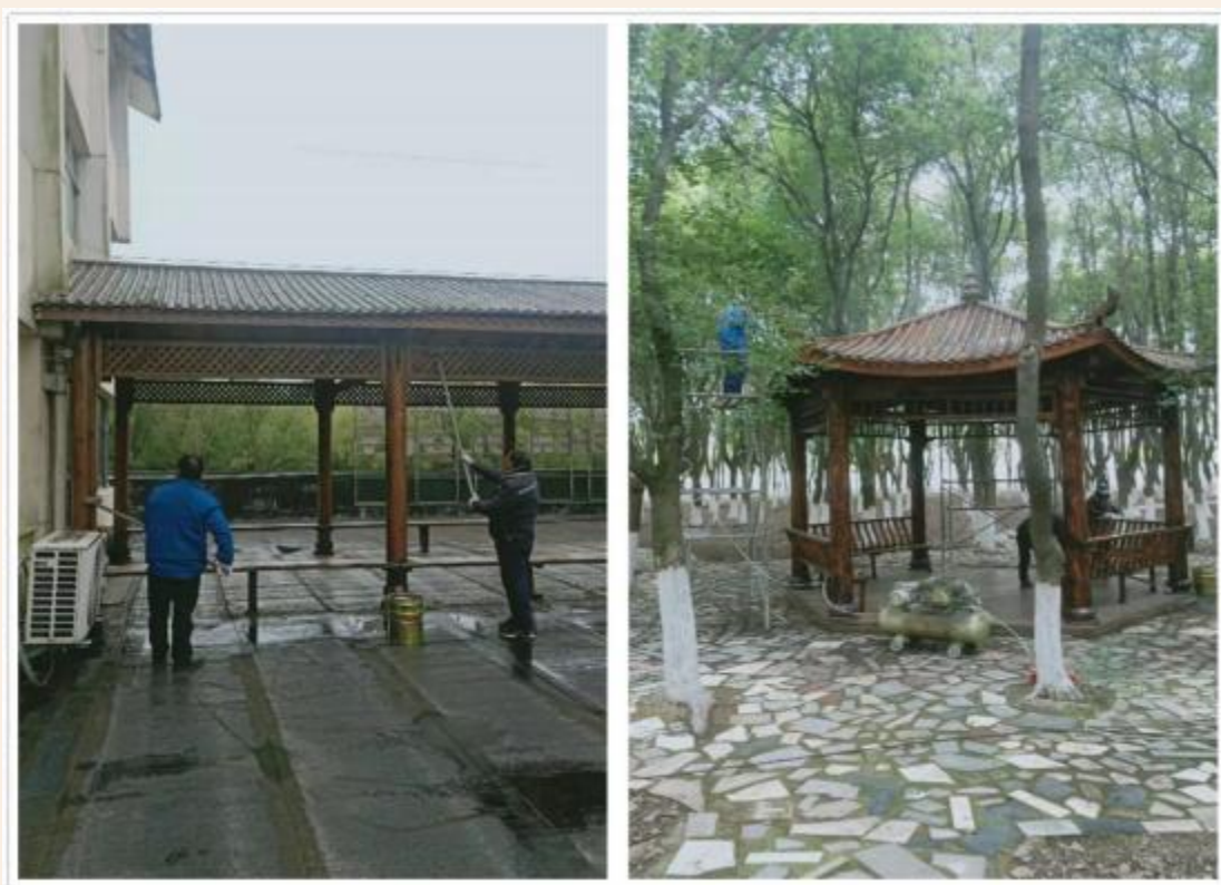
(对木制亭进行保养刷油)
