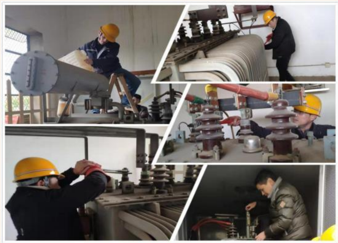
(6 台 1000KVA 油变检修、维护)
