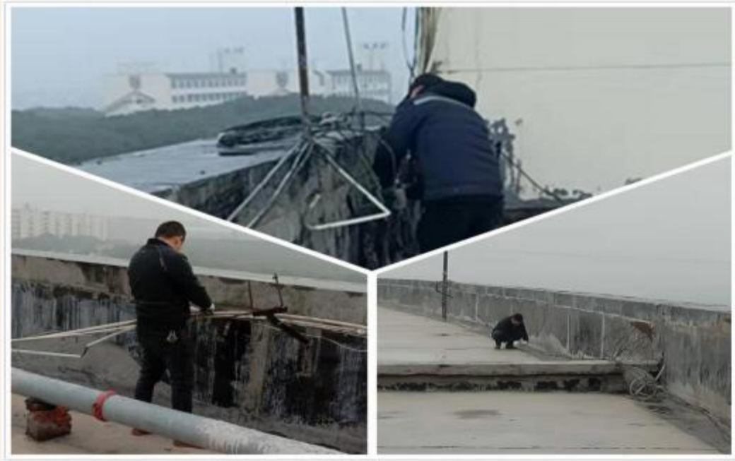
(主教学楼楼顶整理线路)
